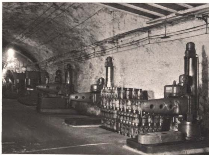
Durante la loro occupazione in Italia, i tedeschi avevano trasformato le gallerie della Gardesana occidentale, nei pressi di Riva, in uno stabilimento lungo 10 chilometri: qui, con macchinario sottratto alla Fiat, costruivano motori per aerei.
